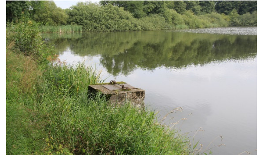
Für den Erhalt der Teichlandschaft sind in den kommenden Jahren wasserbauliche Sanierungsmaßnahmen notwendig.
